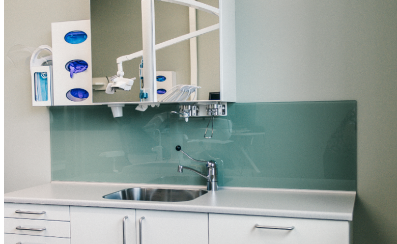
Bänkskiva i Dandent hygienlaminat med underlimmad rostfri ho utan breddavlopp.
